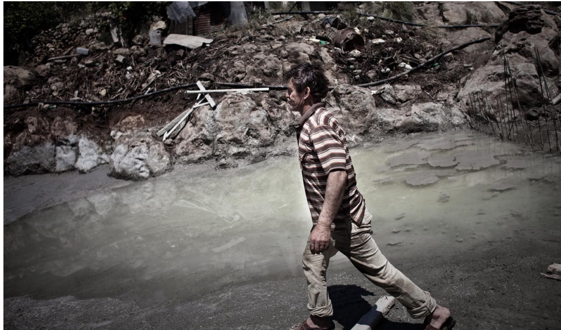
↑ EN PALESTINSK MAN FRÅN BYN WAD QANA GÅR ÖVER DEN NYLAGDA CEMENTEN. TIDIGARE HAR OMKRING 50 PROCENT AV ALLT VATTEN FÖRSVUNNIT NER I JORDEN. MED DENNA NYA VATTENRESERVOAR PLANE-RAR MAN ATT MER EFFEKTIVT TA TILLVARA DET DYRBARA VATTNET.
